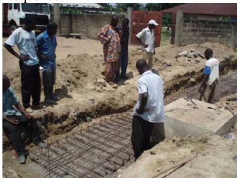
Figure 6: Travaux de construction du réseau des eaux usées et des caniveaux dans la zone d'Ewawu (Kara Togo, Août 2009)
