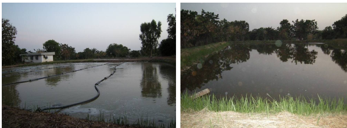
Figure 2 : Bassin anaérobie avec système d'insufflation d'air et Bassin de maturation
